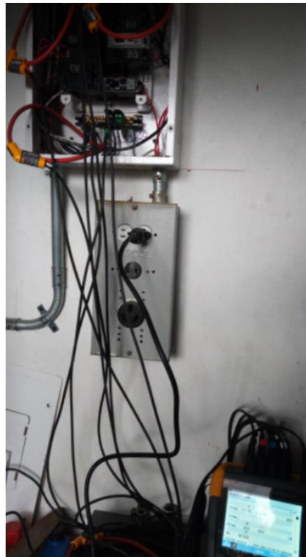
Figura 25. Instalación del equipo en tablero de cuarto fríos.
